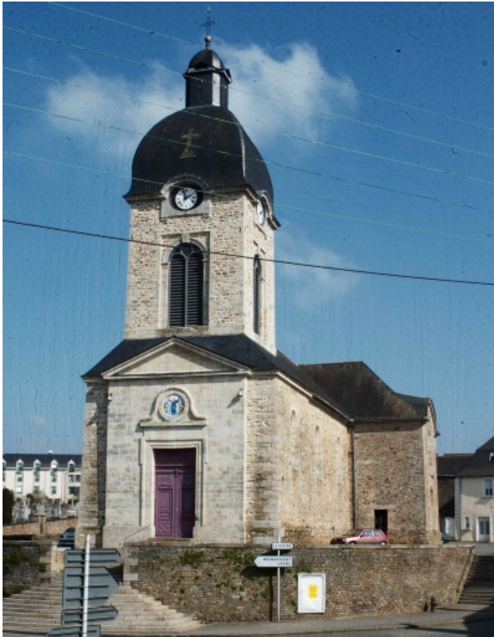
Vue générale ouest
