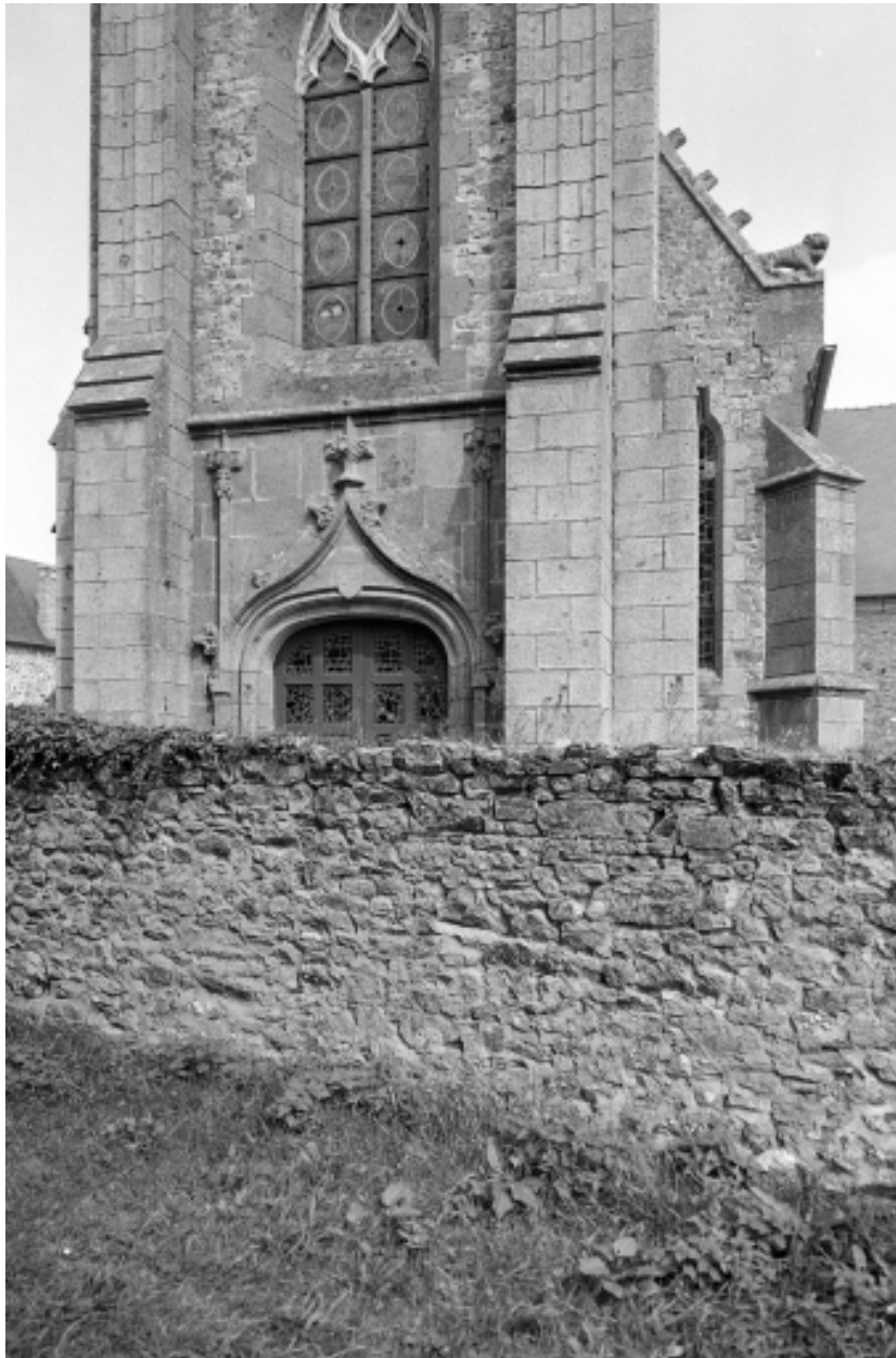
Façade ouest, vue générale.
