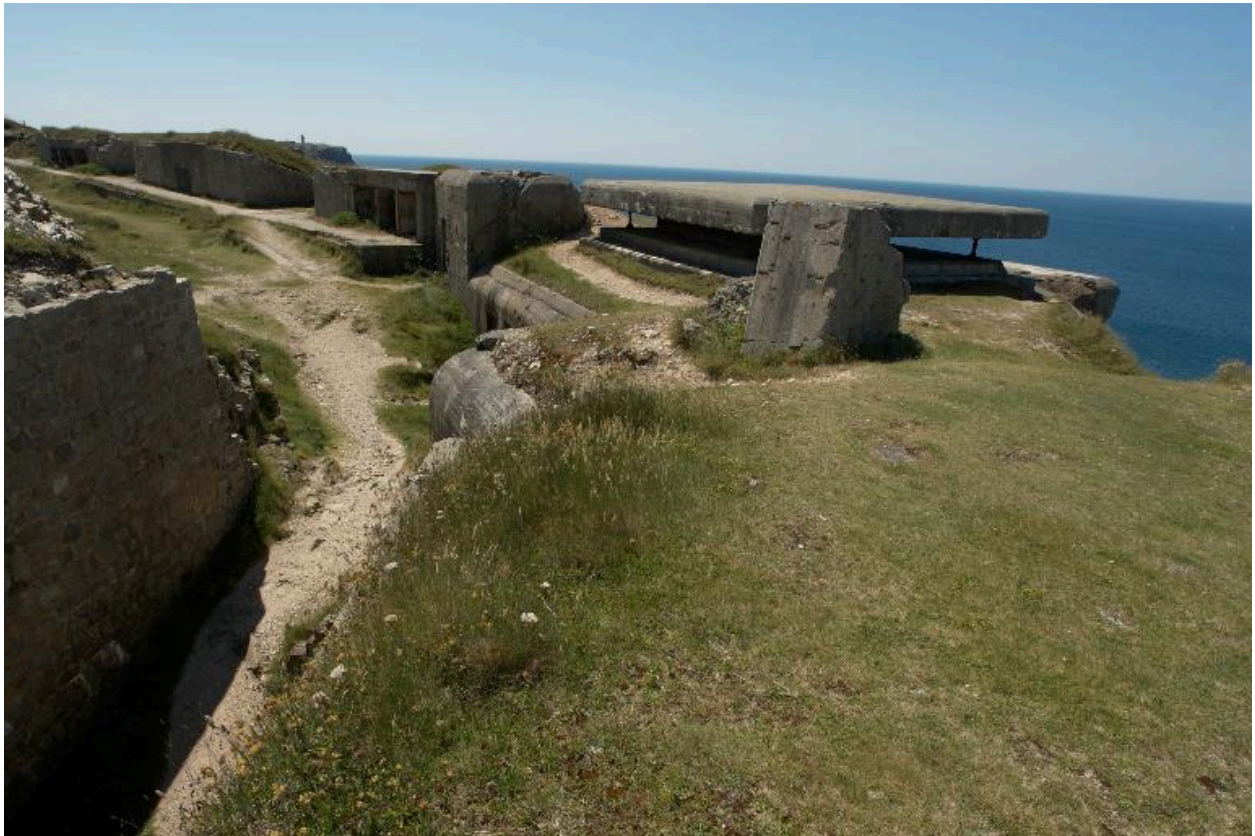
Vue de situation du bunker - poste de direction de tir de type M162a
