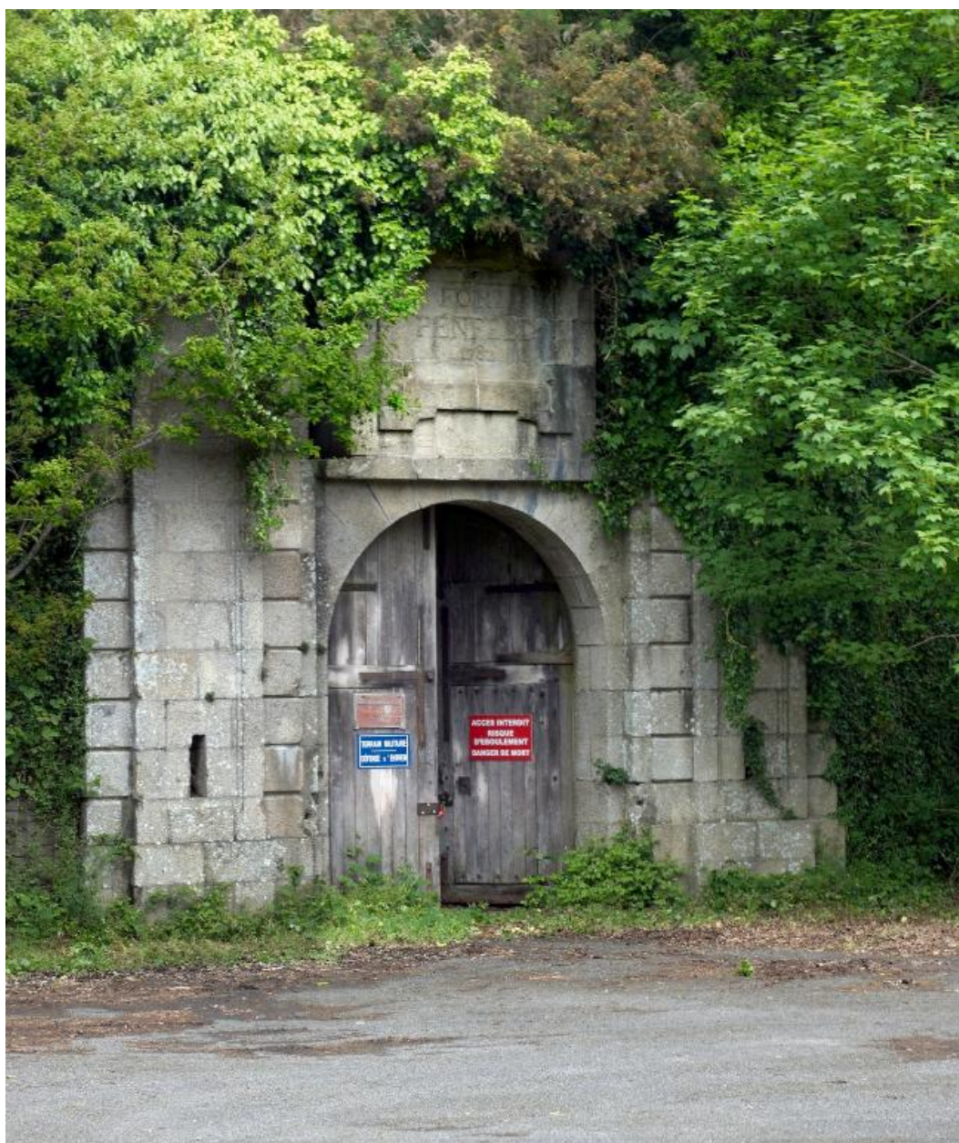
Brest : le fort de Penfeld, porte monumentale, photographie réalisée le 13 mai 2009
