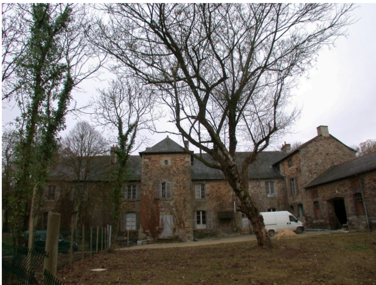
Vue générale de la façade arrière
