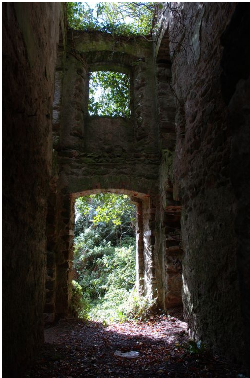
Vue de la caserne (état en 2007)
