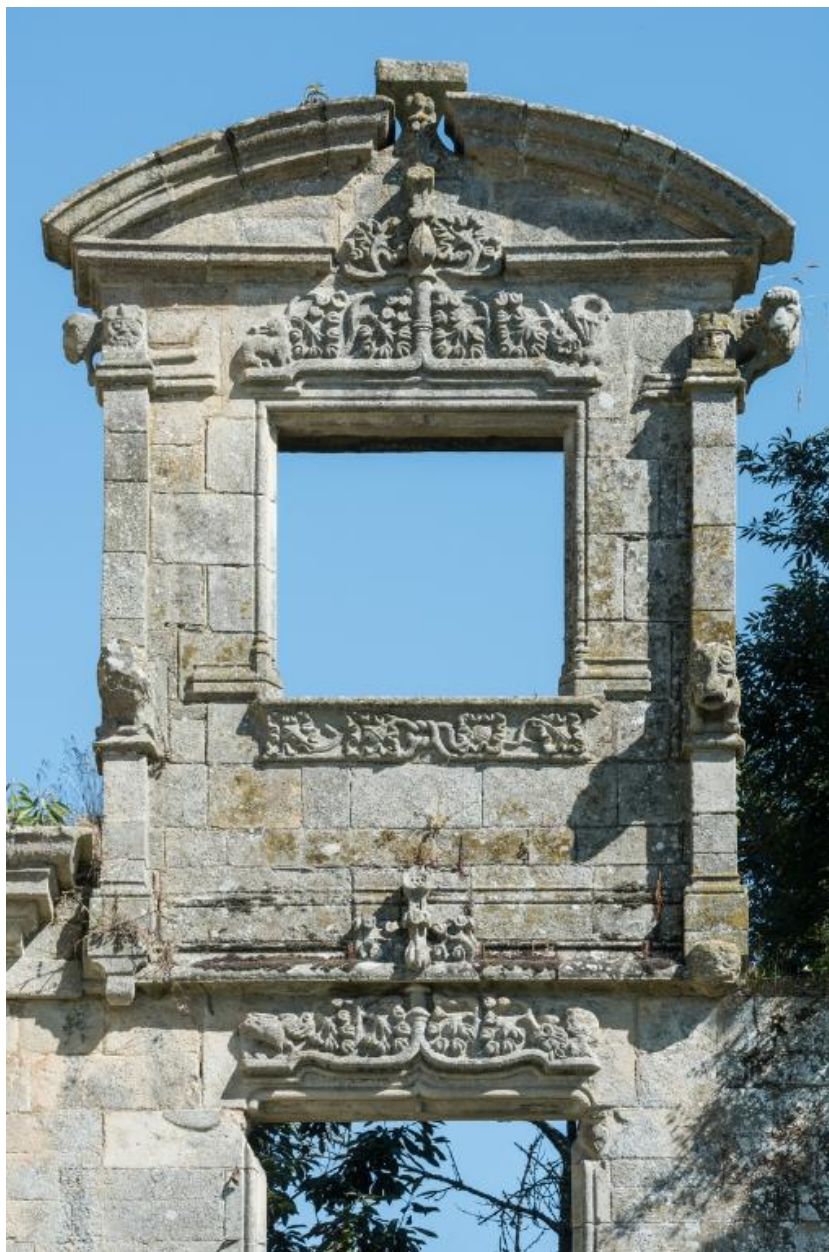
Le château : partie est, lucarne transformée
