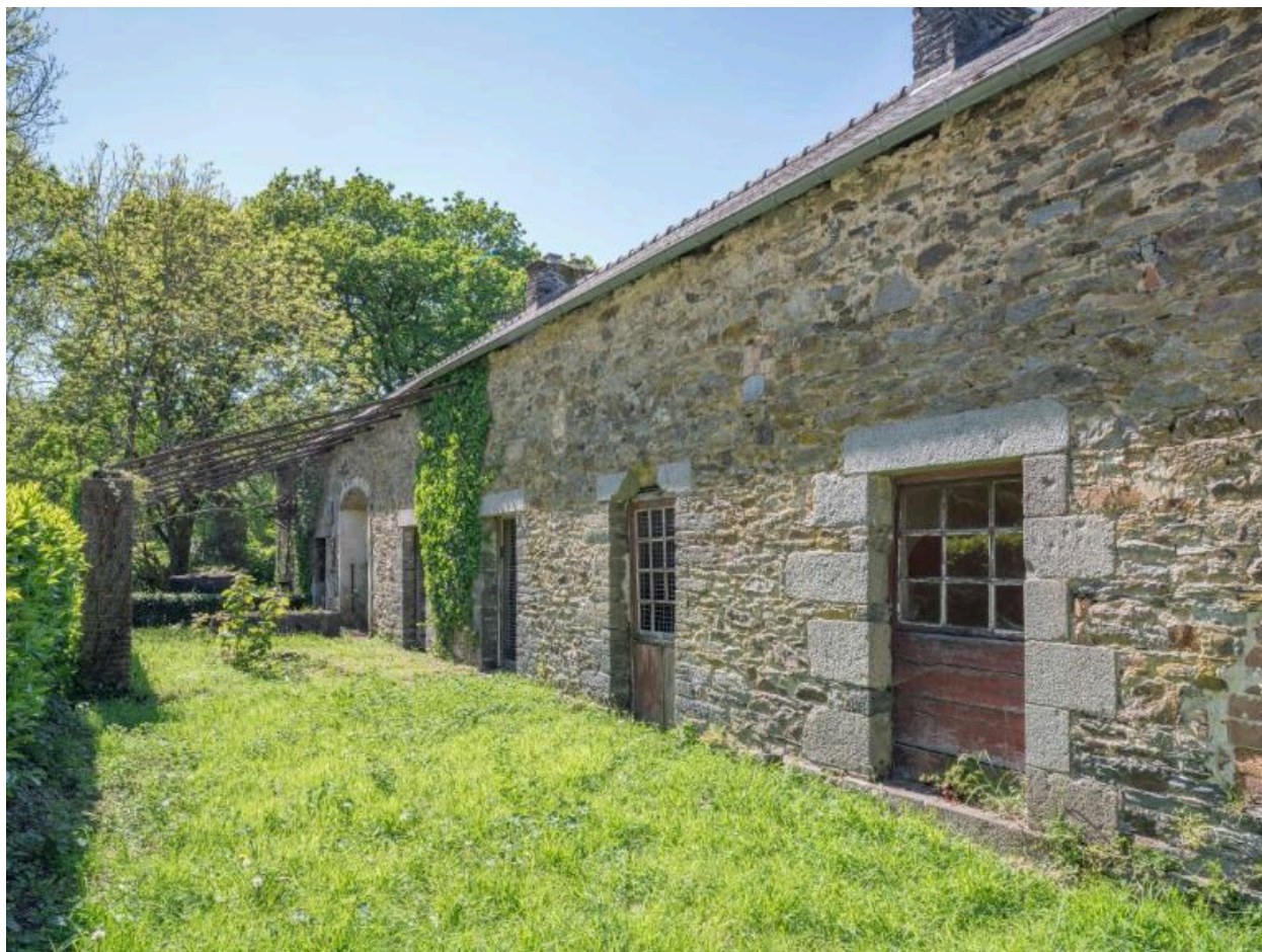
Bâtiment principal. Façade arrière sud-est
