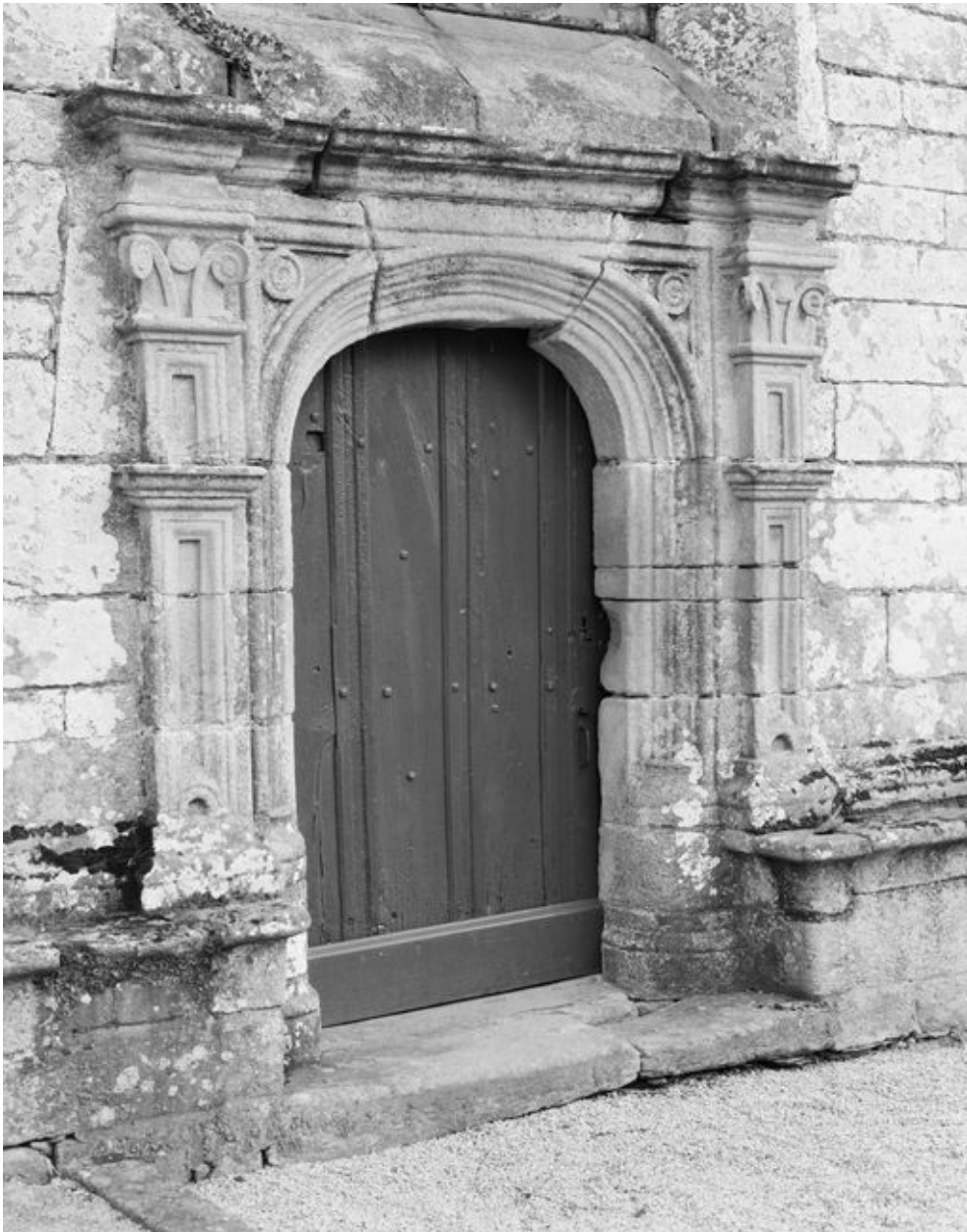
Chapelle, bras sud du transept, élévation sud : le portail (état en 1991)
