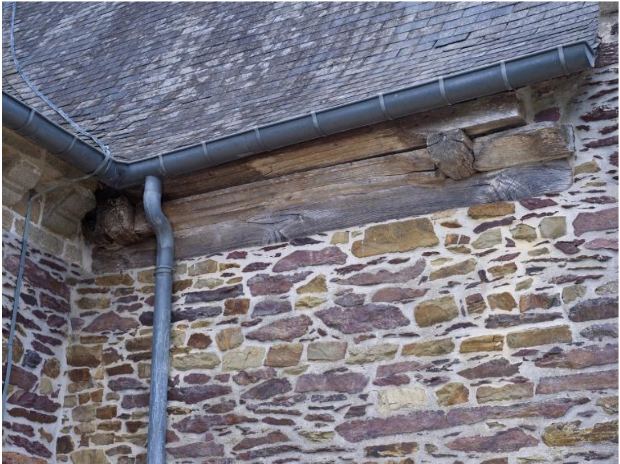
Bras sud du transept : Détail sablière
