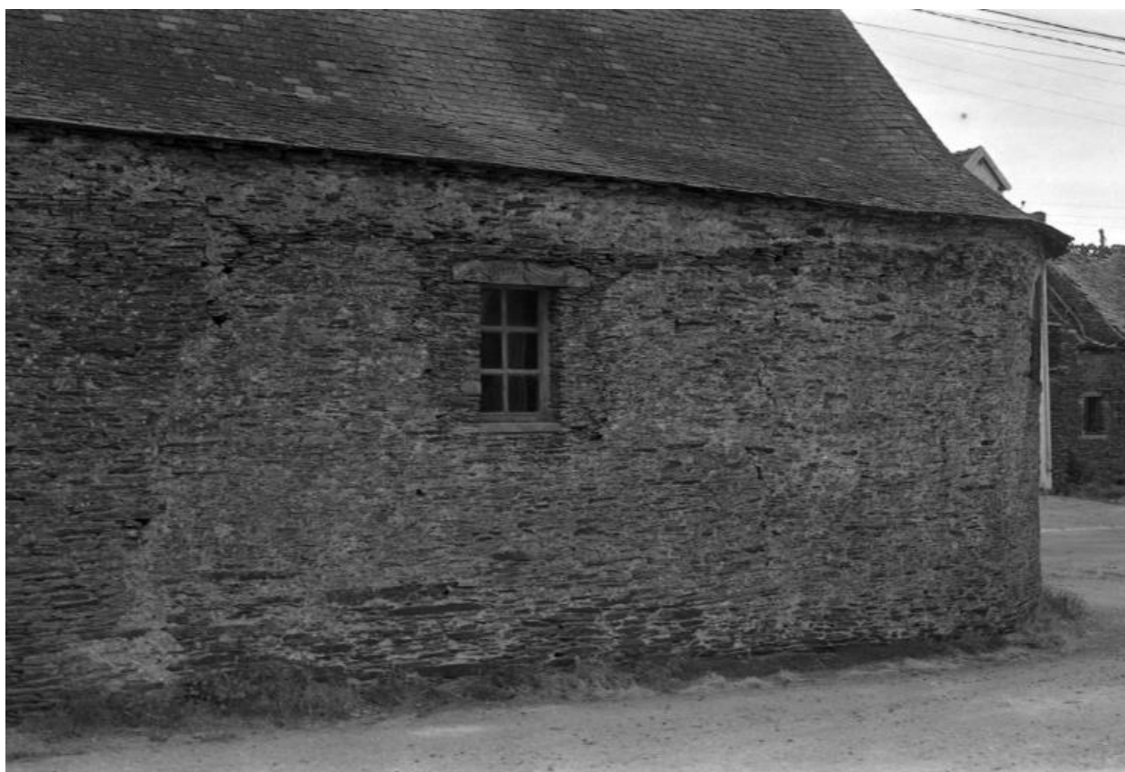
Vue du mur ouest
