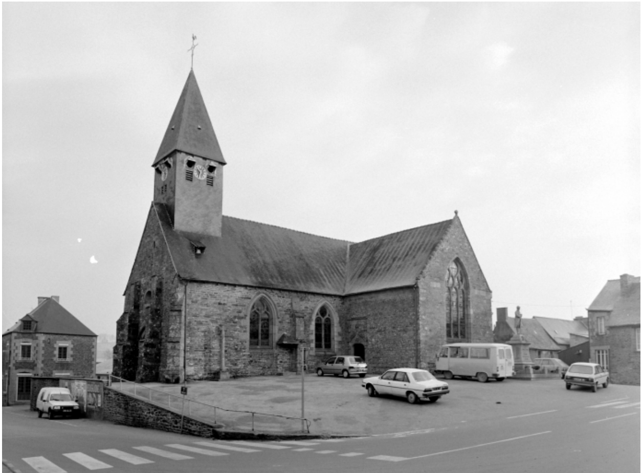
Elévation Sud-Ouest : vue générale
