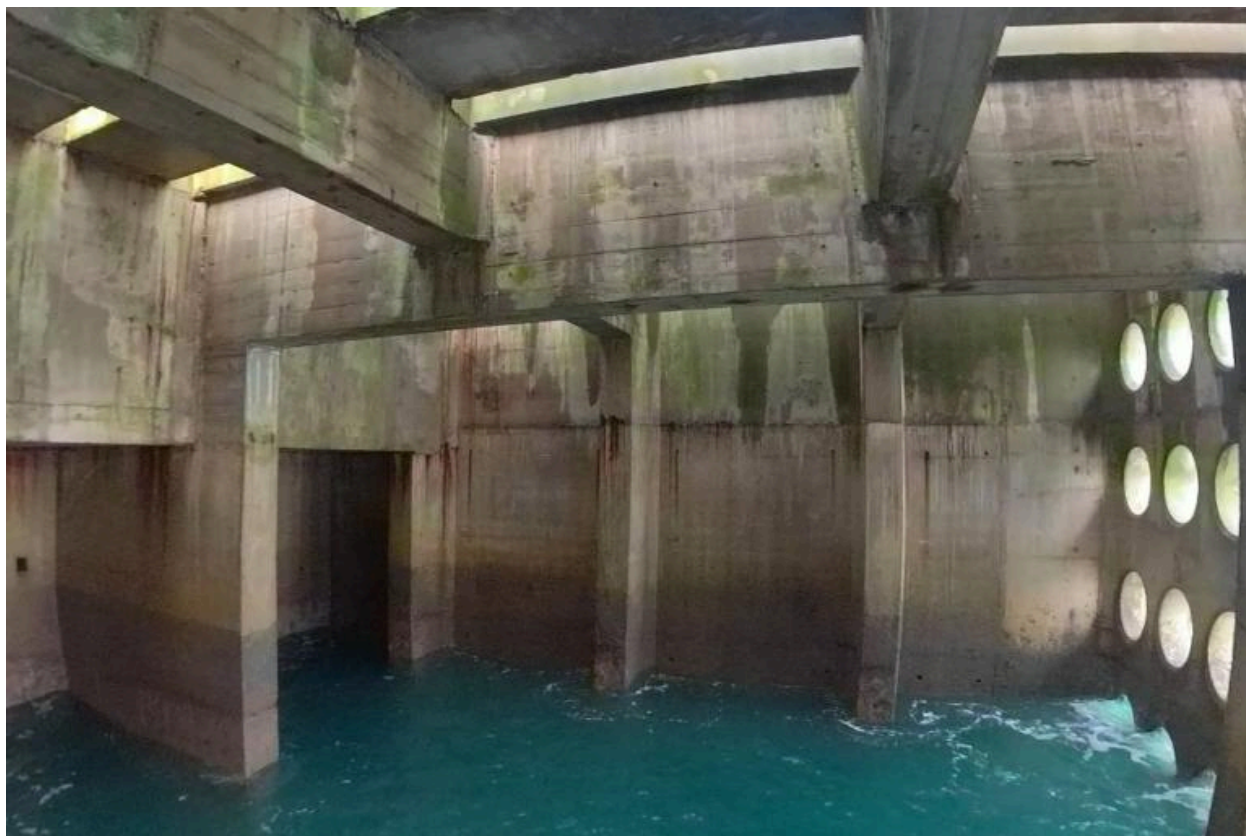
Digue Jarlan, caisson 3, vue intérieure
