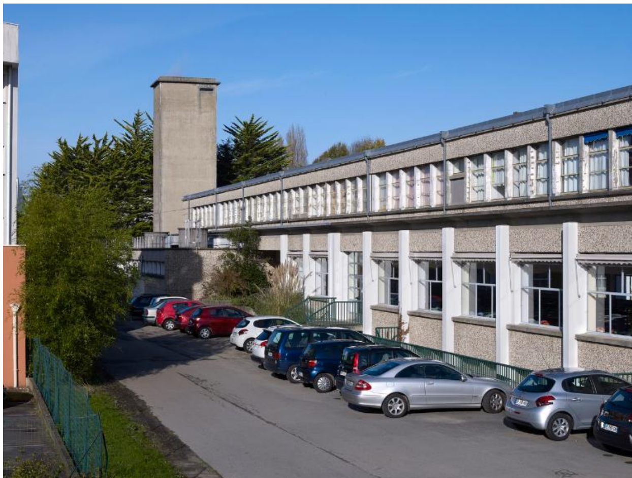
Service de restauration et chaufferie (R. Ouvré et G. Tourry architectes), vue d'ensemble prise du sud-ouest.
