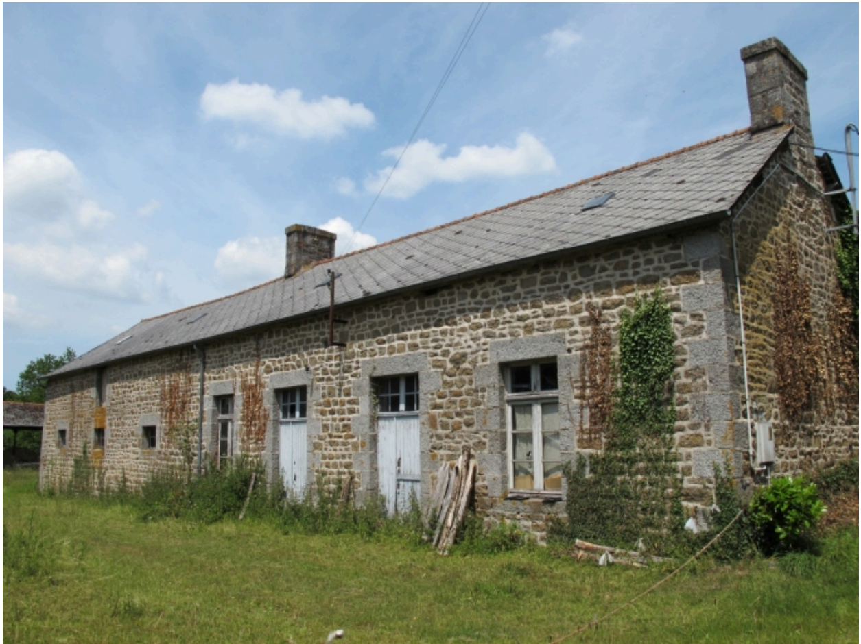
La ferme du château : partie habitation
