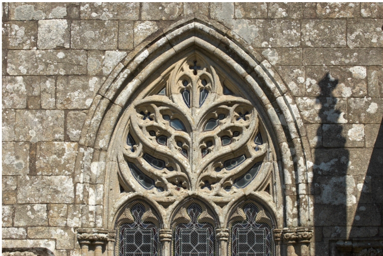
Chapelle sud-ouest, détail réseau de la fenêtre
