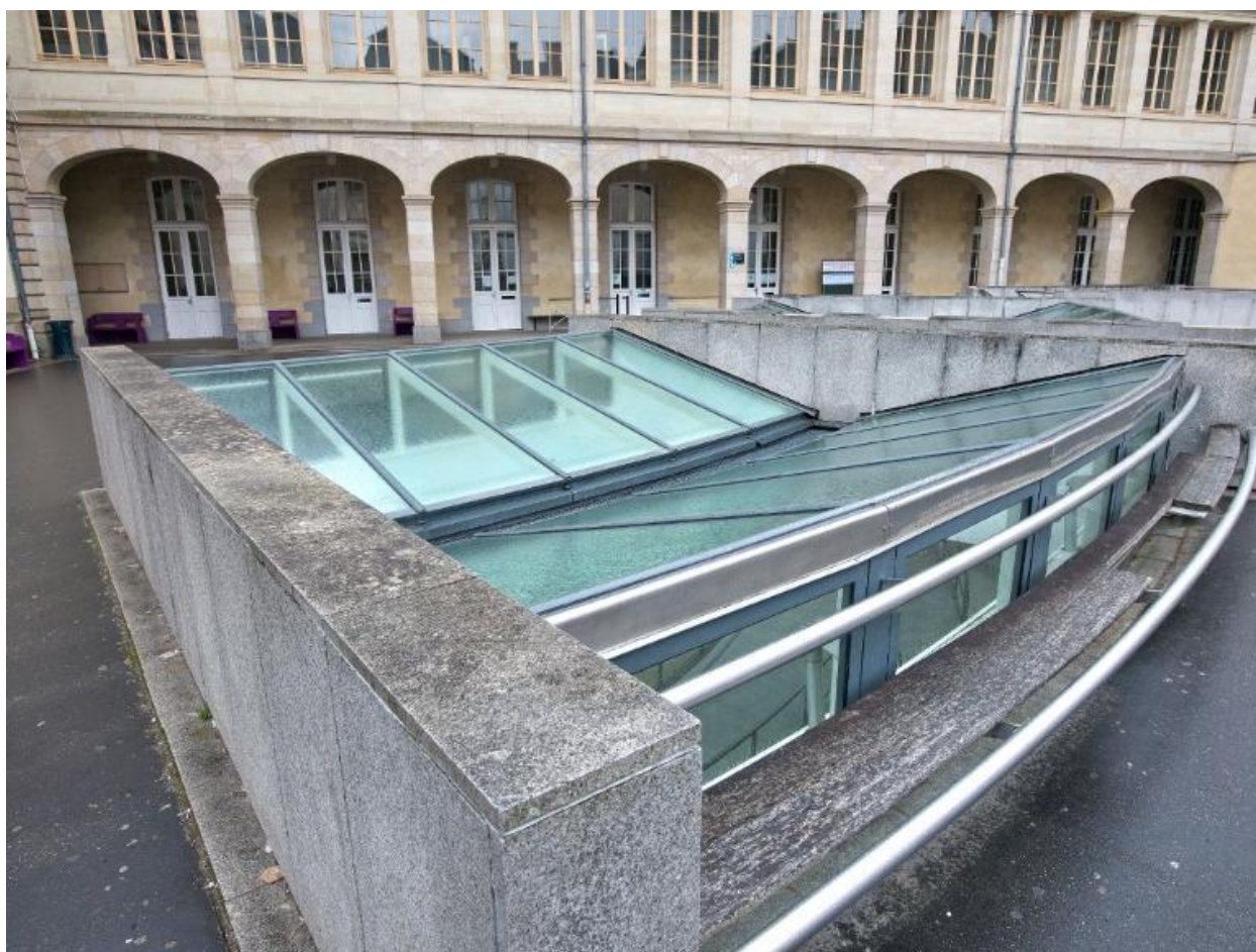
Une des deux verrières du restaurant scolaire. J. Y. Gautier, architecte.
