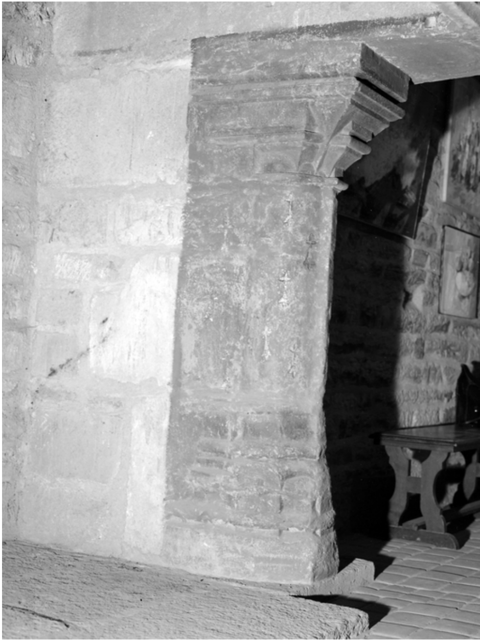
Tour sud-ouest, deuxième niveau - Cheminée, détail d'un piédroit.
