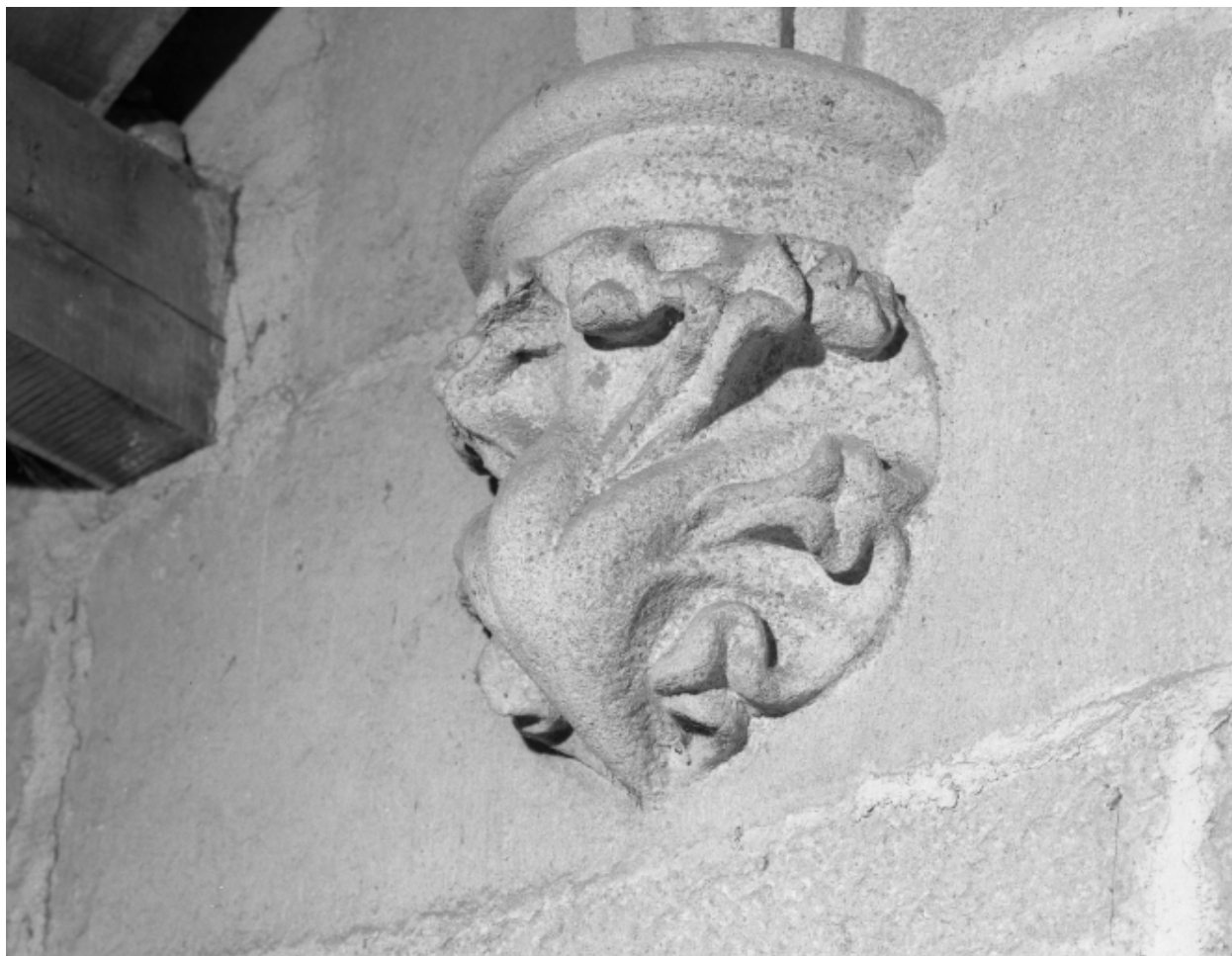
Escalier, 2ème repos du rez-de-chaussée : détail du cul-de-lampe sud ouest
