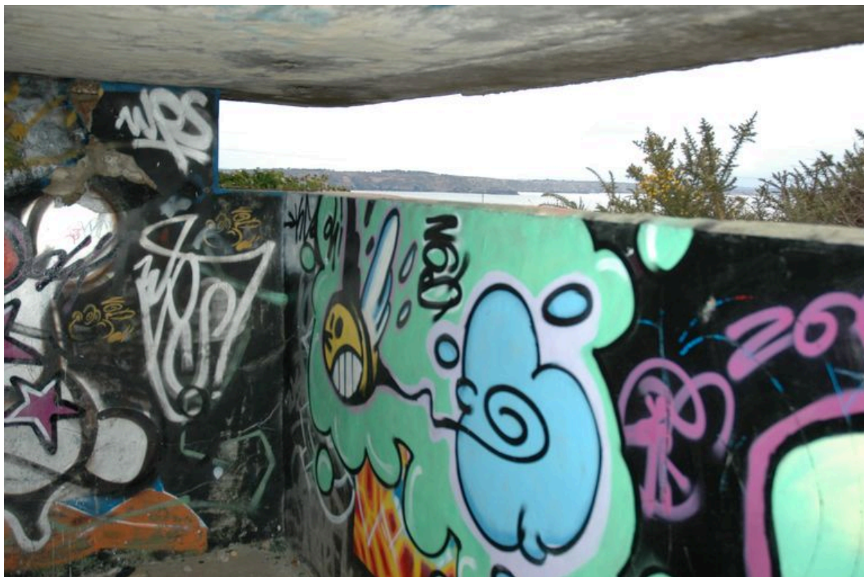
Vue du poste de commandement implanté sur l'abri à munition est (état en 2005)
