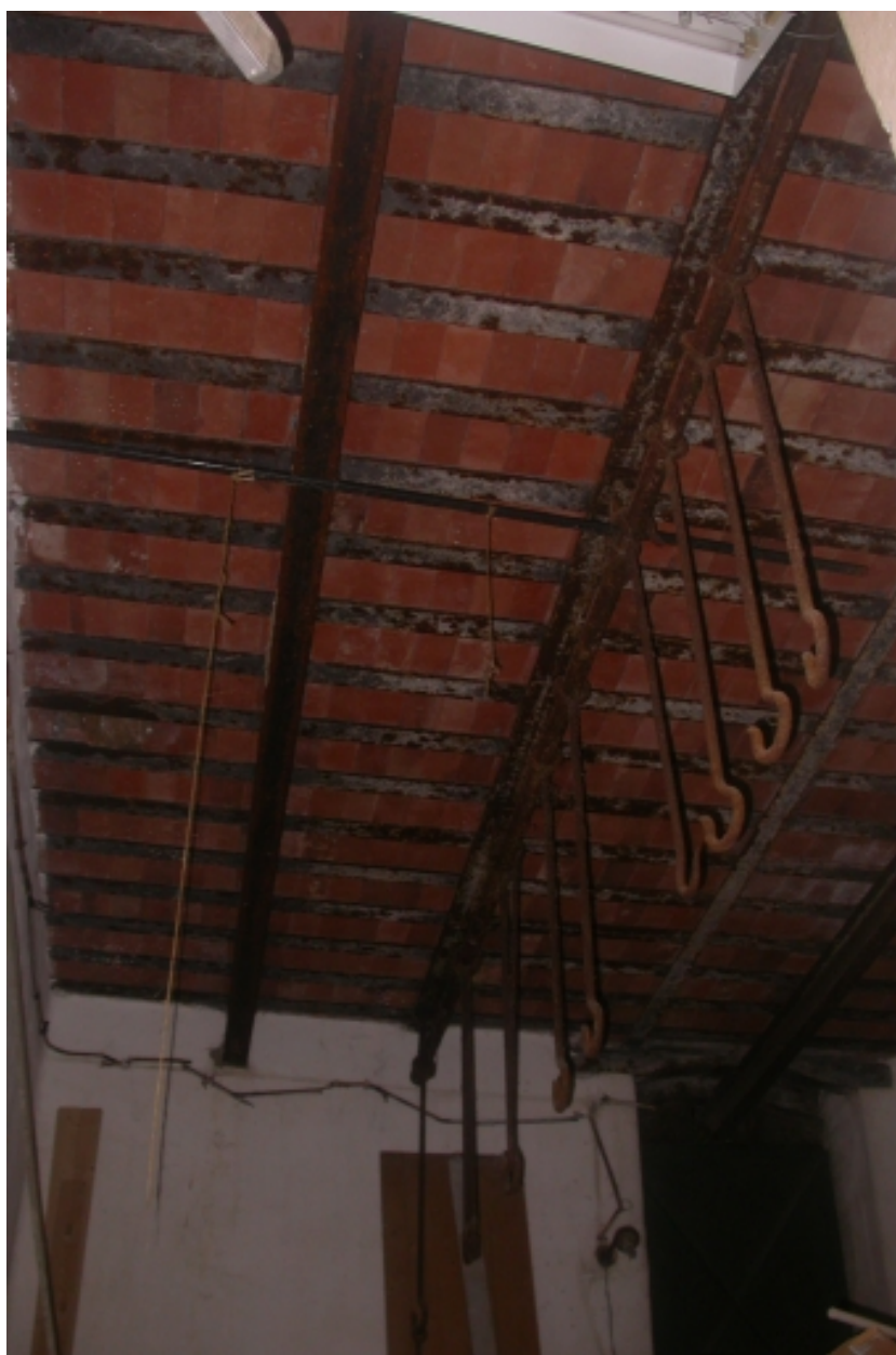
Intérieur d'une ancienne chambre froide
