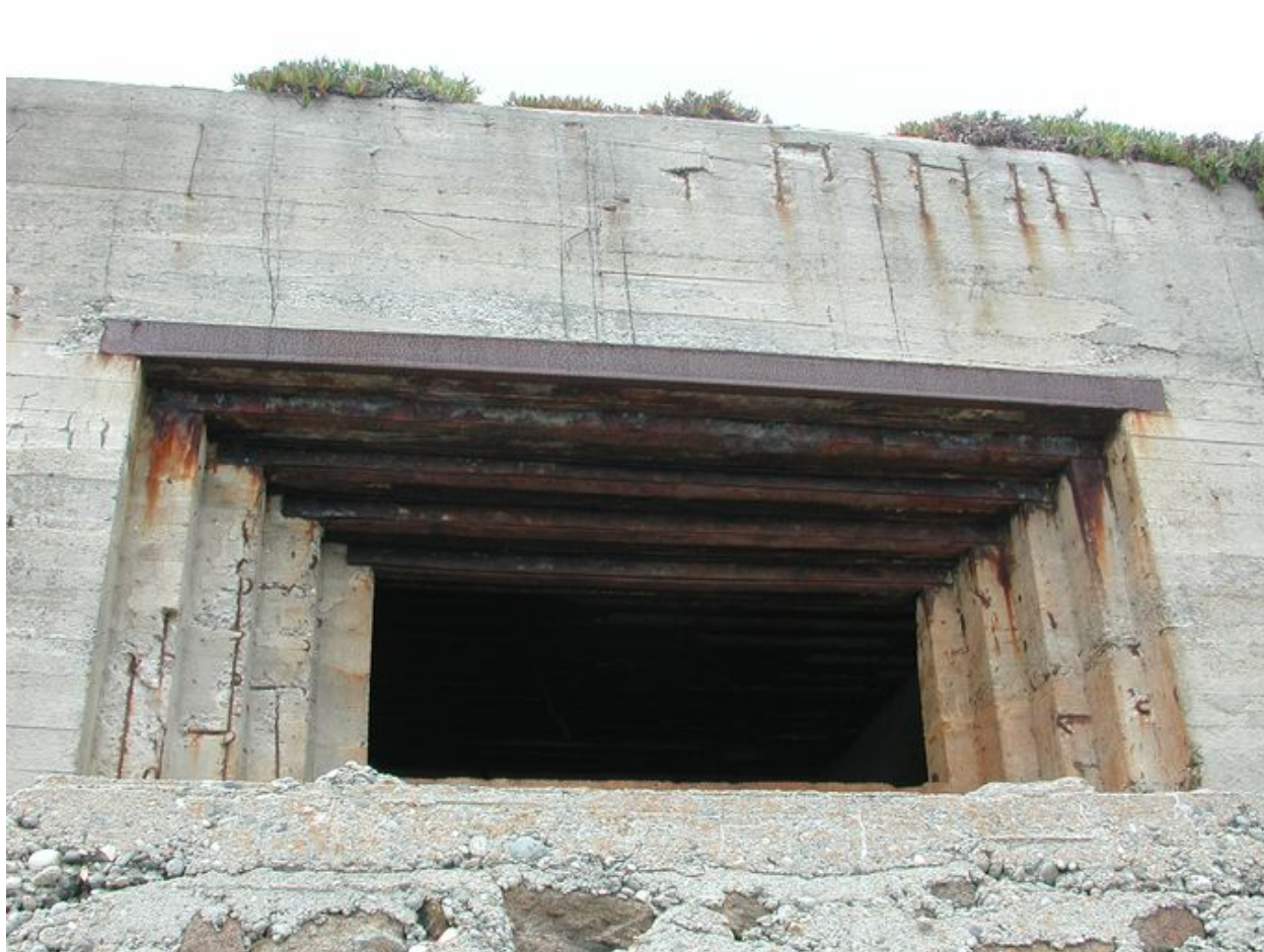
Vue générale de l'embrasure en gradin de la casemate Sud
