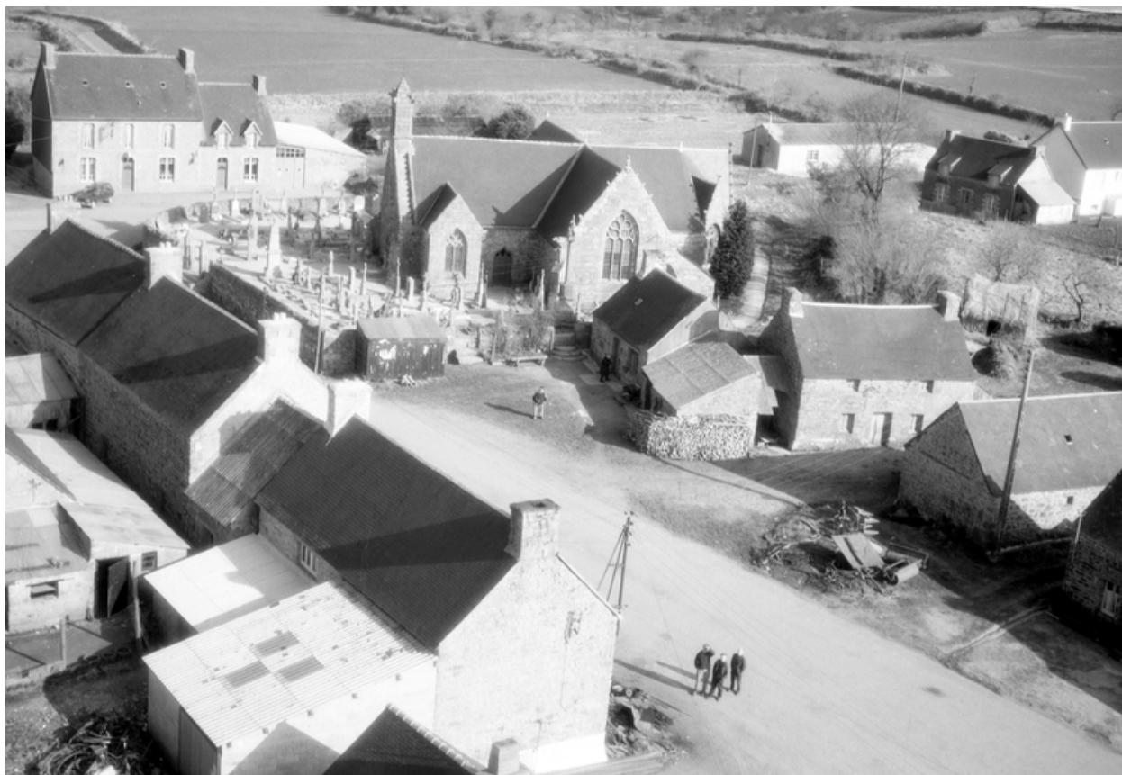
Vue aérienne prise du sud - sud ouest
