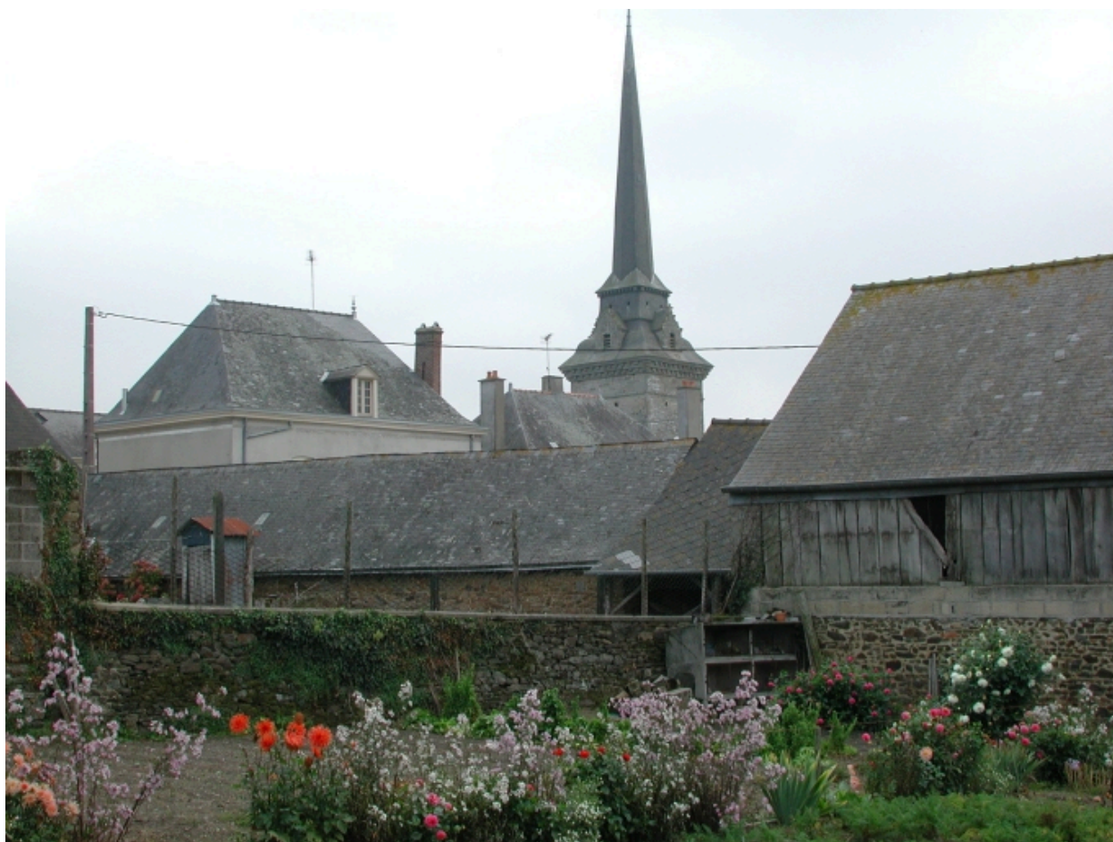
Flèche vue du nord ouest
