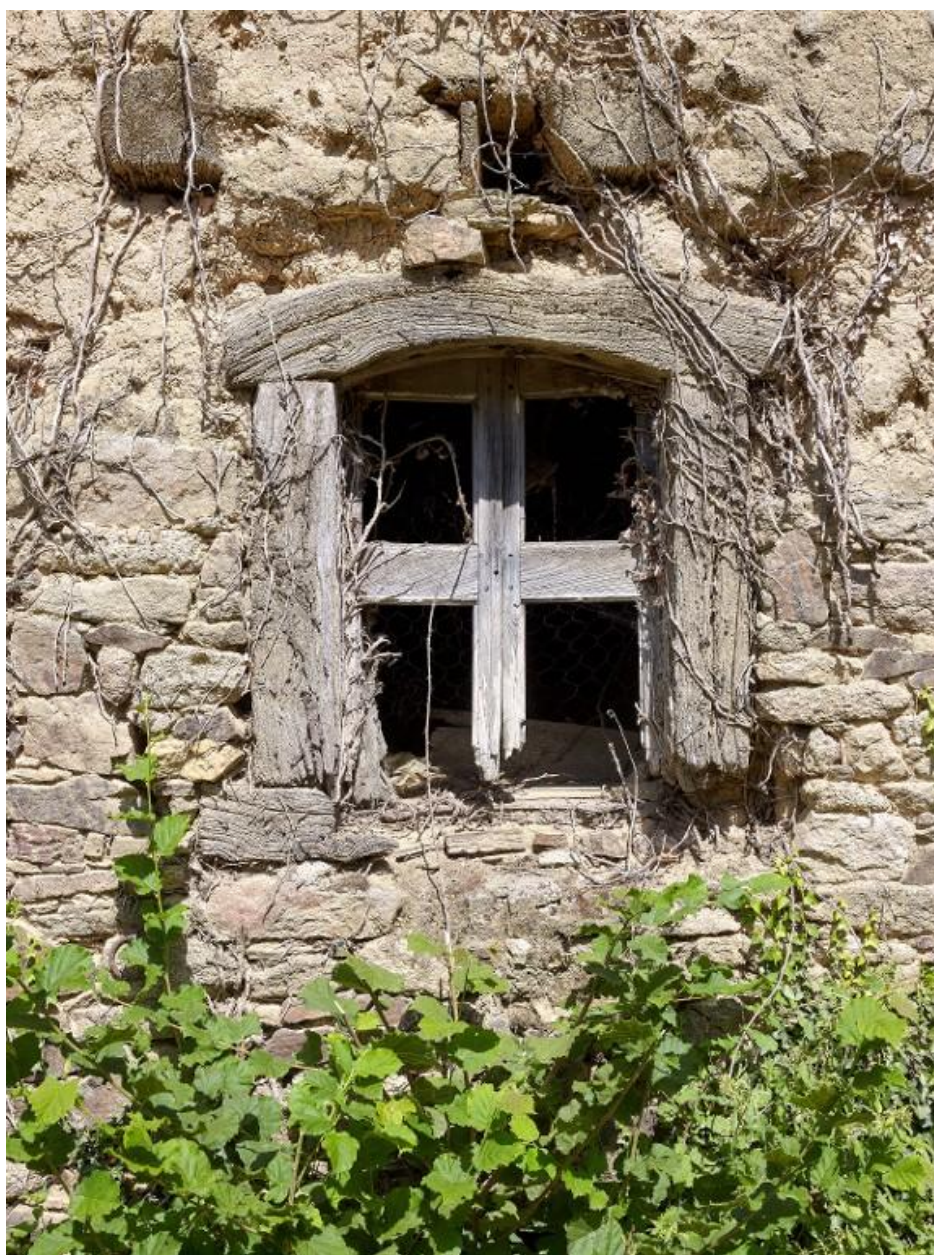
Menuiserie en bois fixé contre la maçonnerie par des clefs horizontales
