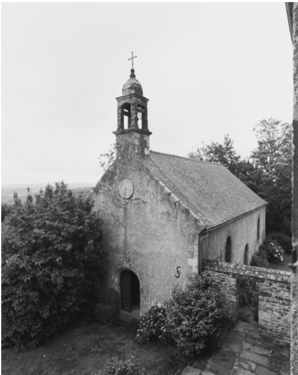
Chapelle, élévations est et nord
