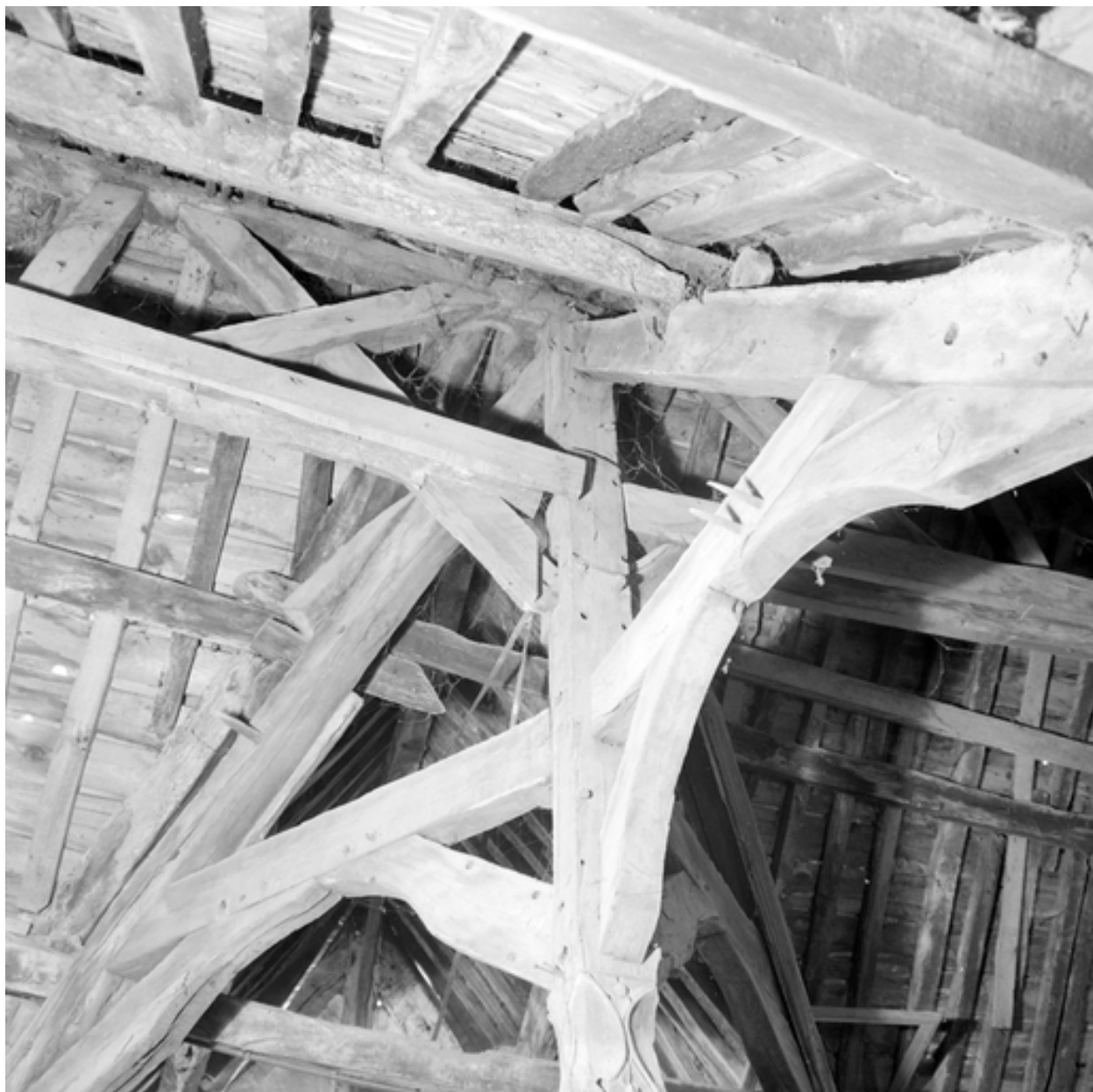
Charpente, vue d'ensemble de l'assemblage central.
