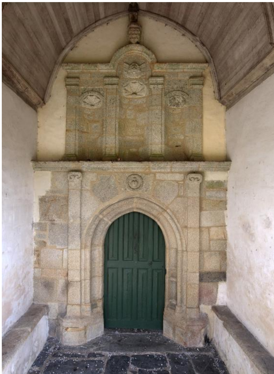
Proche sud, entrée, niches à statues
