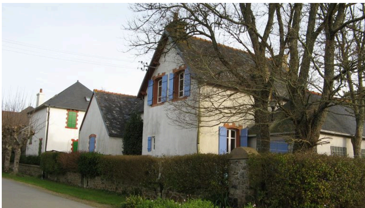
Vue générale de 2 des villas surnommées Les Petites Gares
