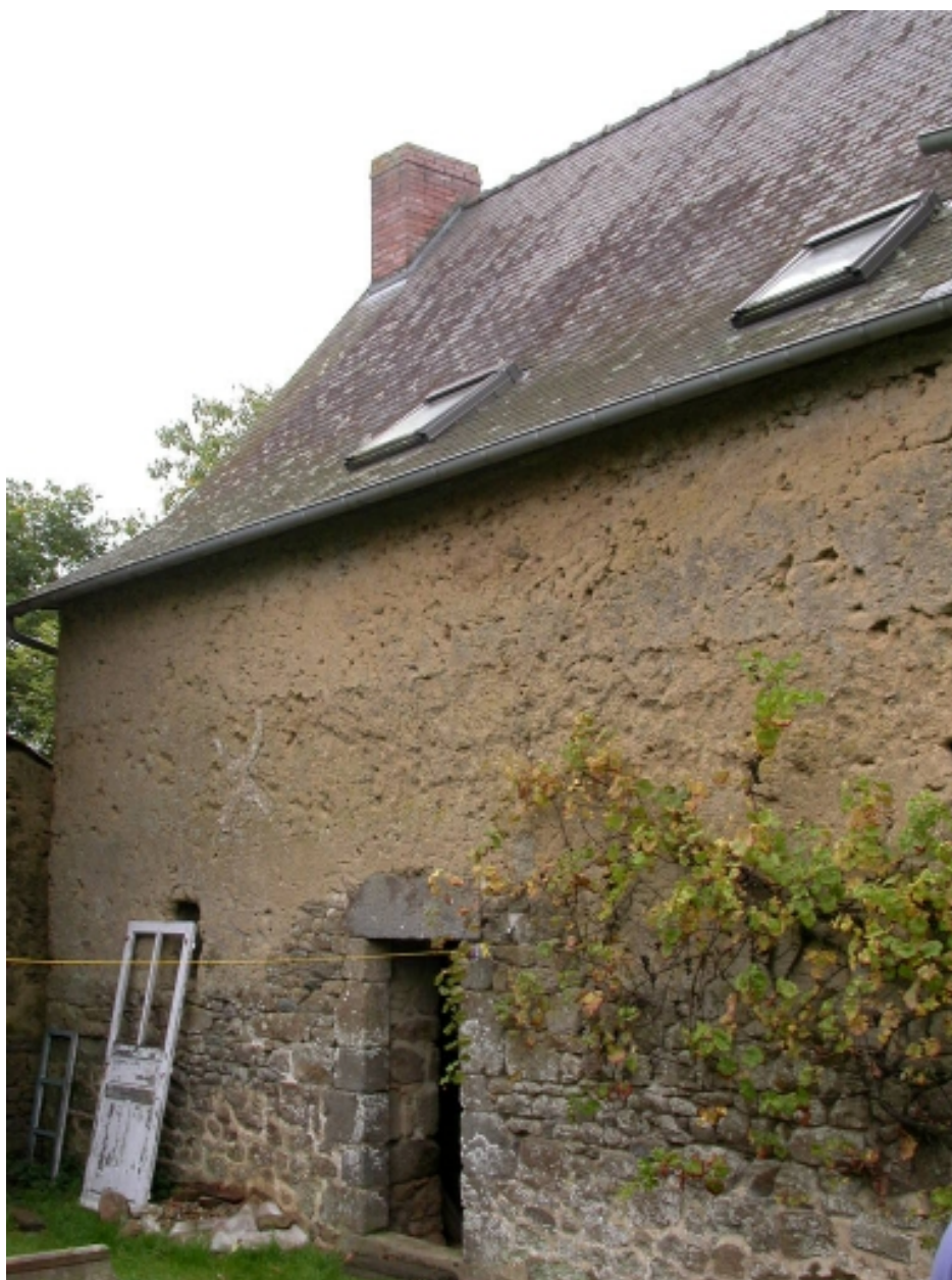
Façade postérieure de la partie nord
