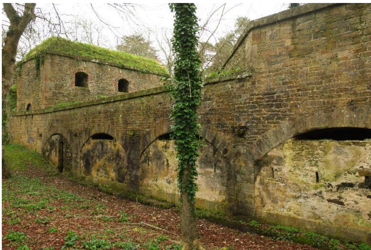
Le Palais, enceinte urbaine, galerie de contrescarpe, casemates à droite du réduit G.
