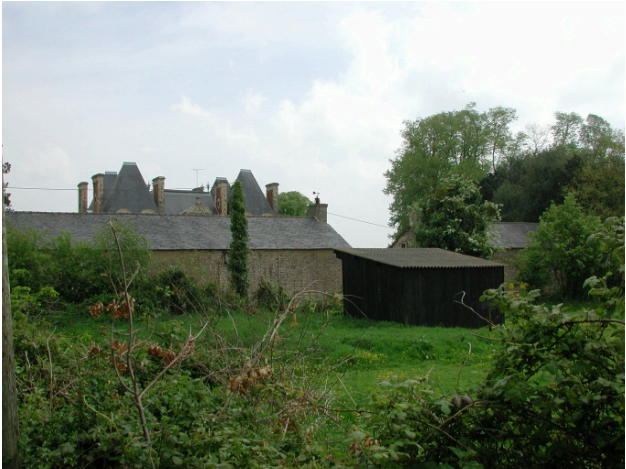
Vue partielle ouest ; silhouette
