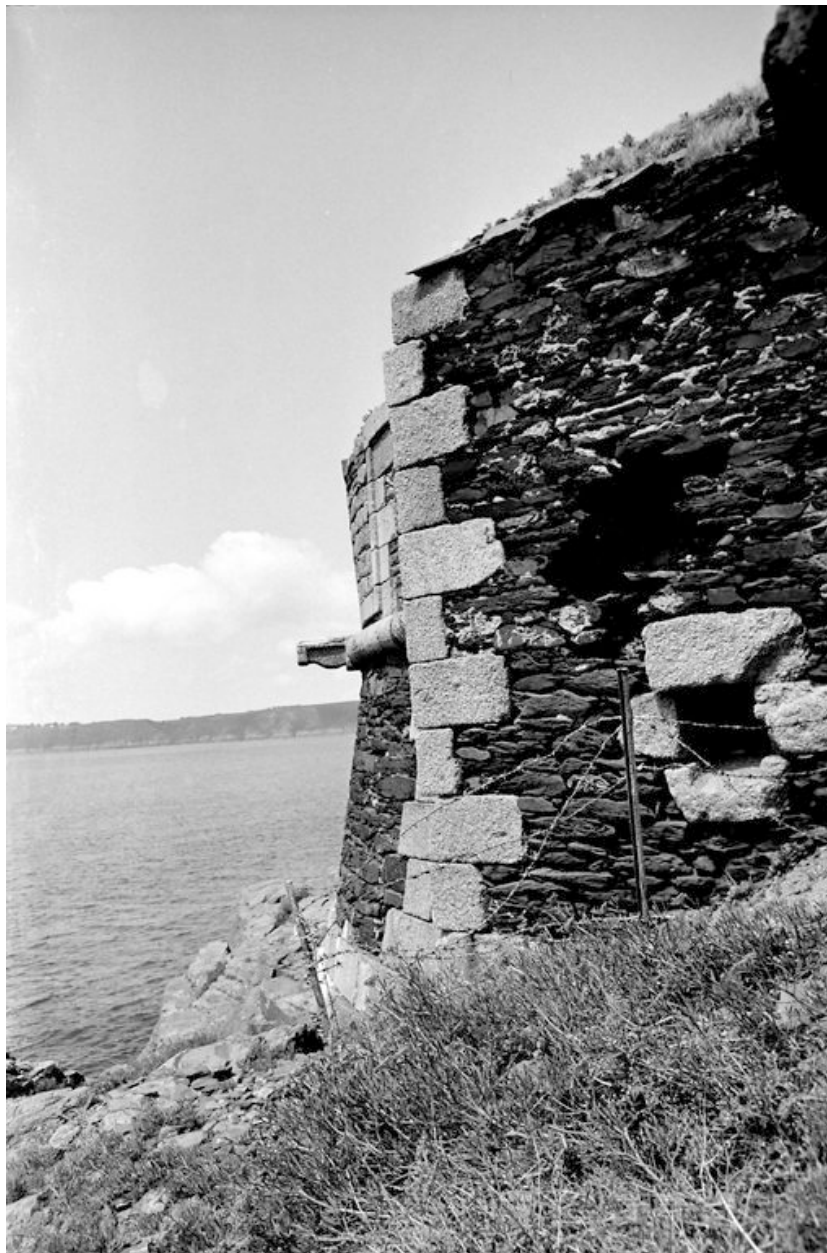
Vue de la batterie de Cornouaille en 1967 : extrémité ouest, escarpe, chaînes harpées en pierres de taille de granite
