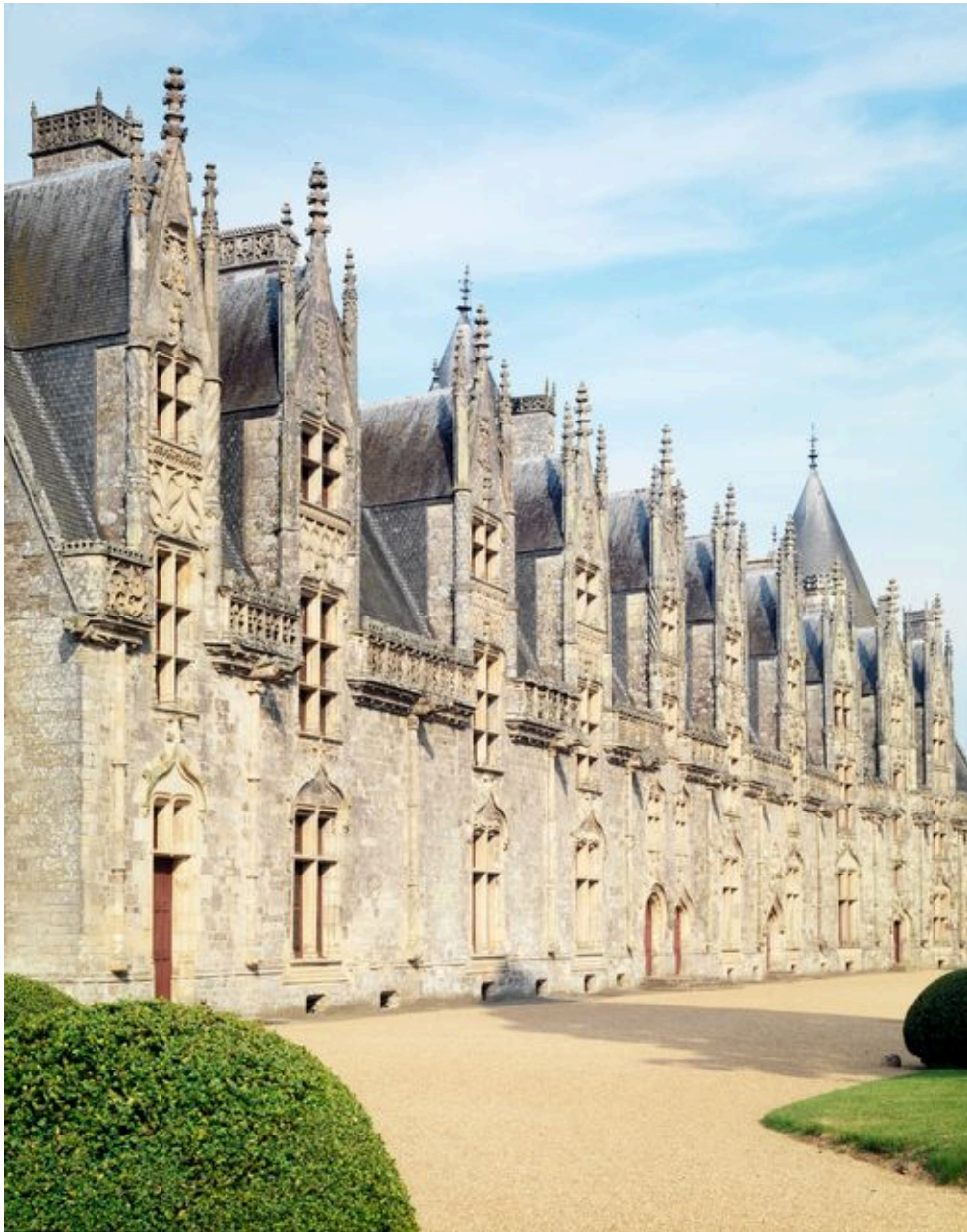
Logis, élévation sur cour : vue générale en enfilade à partir du sud-est
