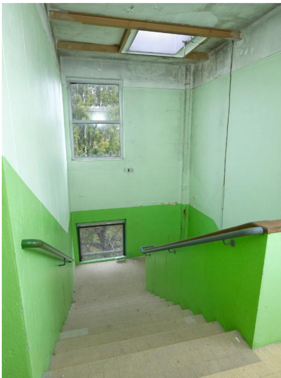
Cage d'escalier nord-ouest, internat de garçons (1954), désaffecté.
