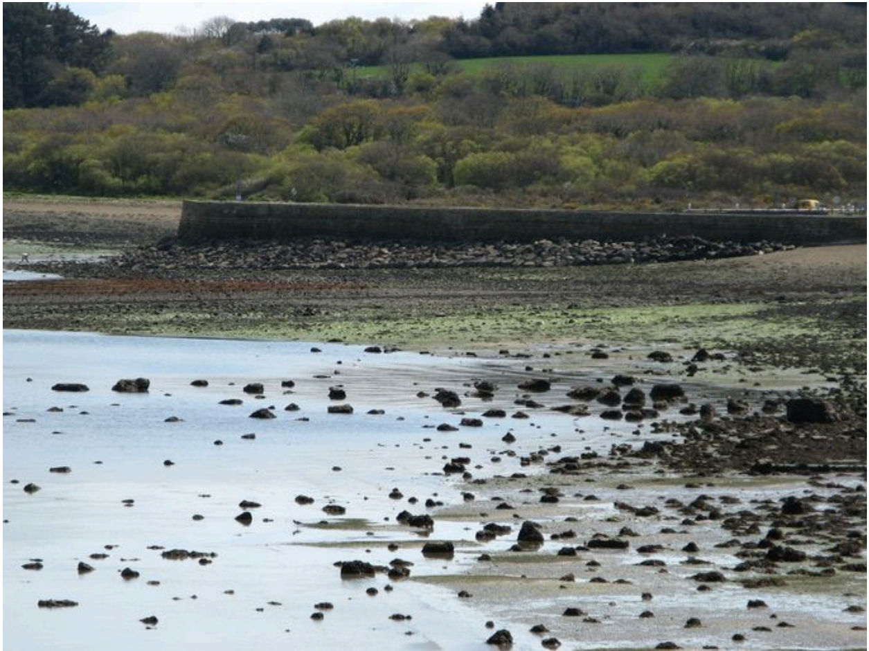
Vue vers le sud de la digue-route de Quéléren
