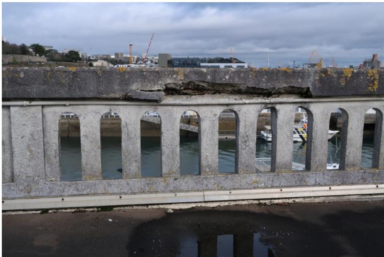
Toit terrasse, garde-corps béton
