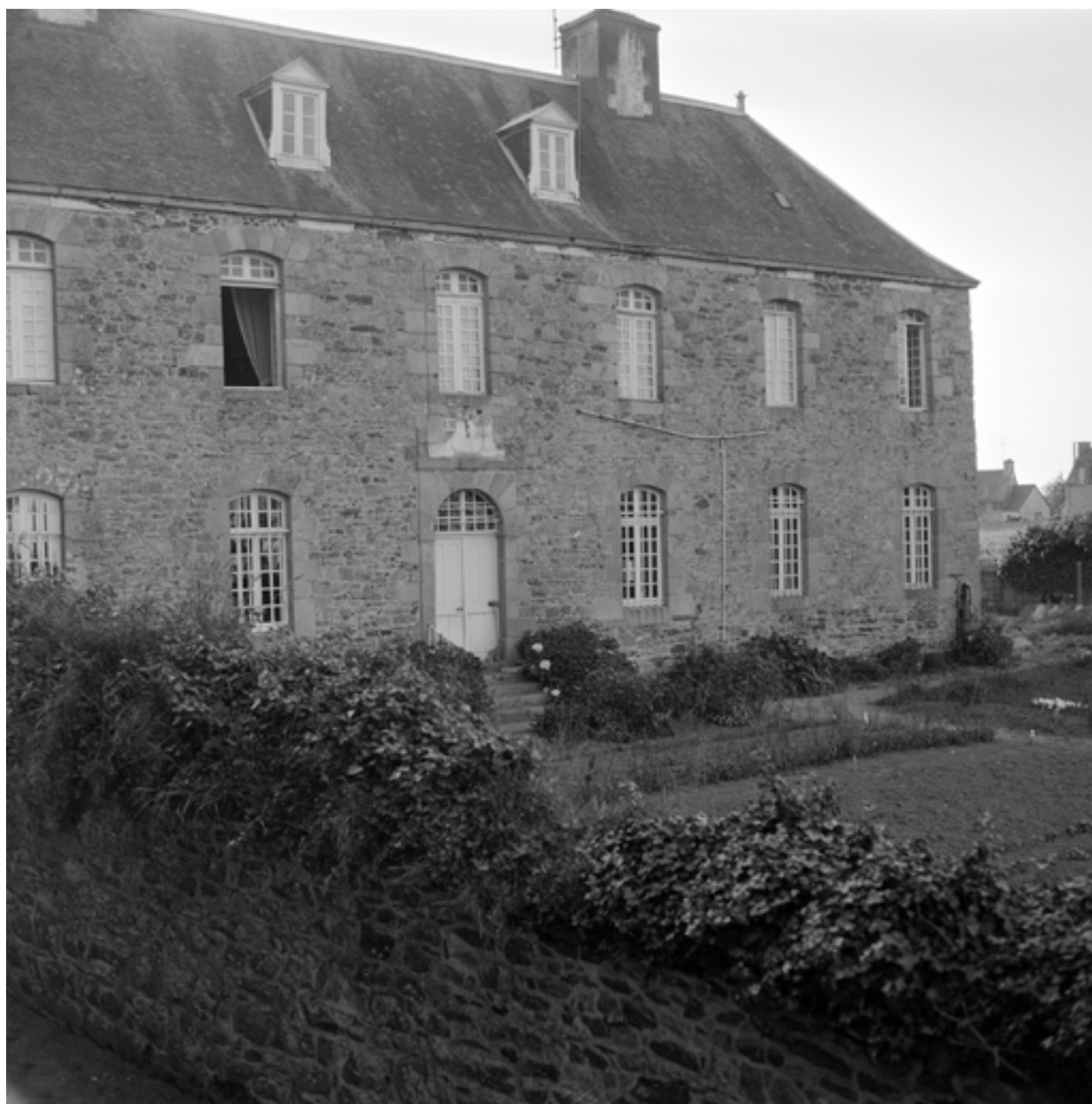
Façade est : vue générale (état en 1974).
