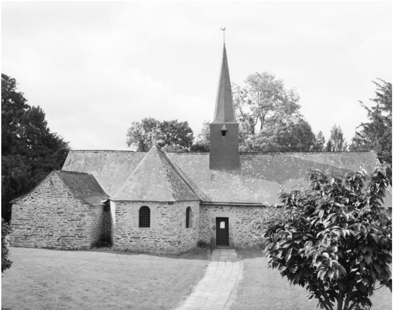
Vue générale prise du nord
