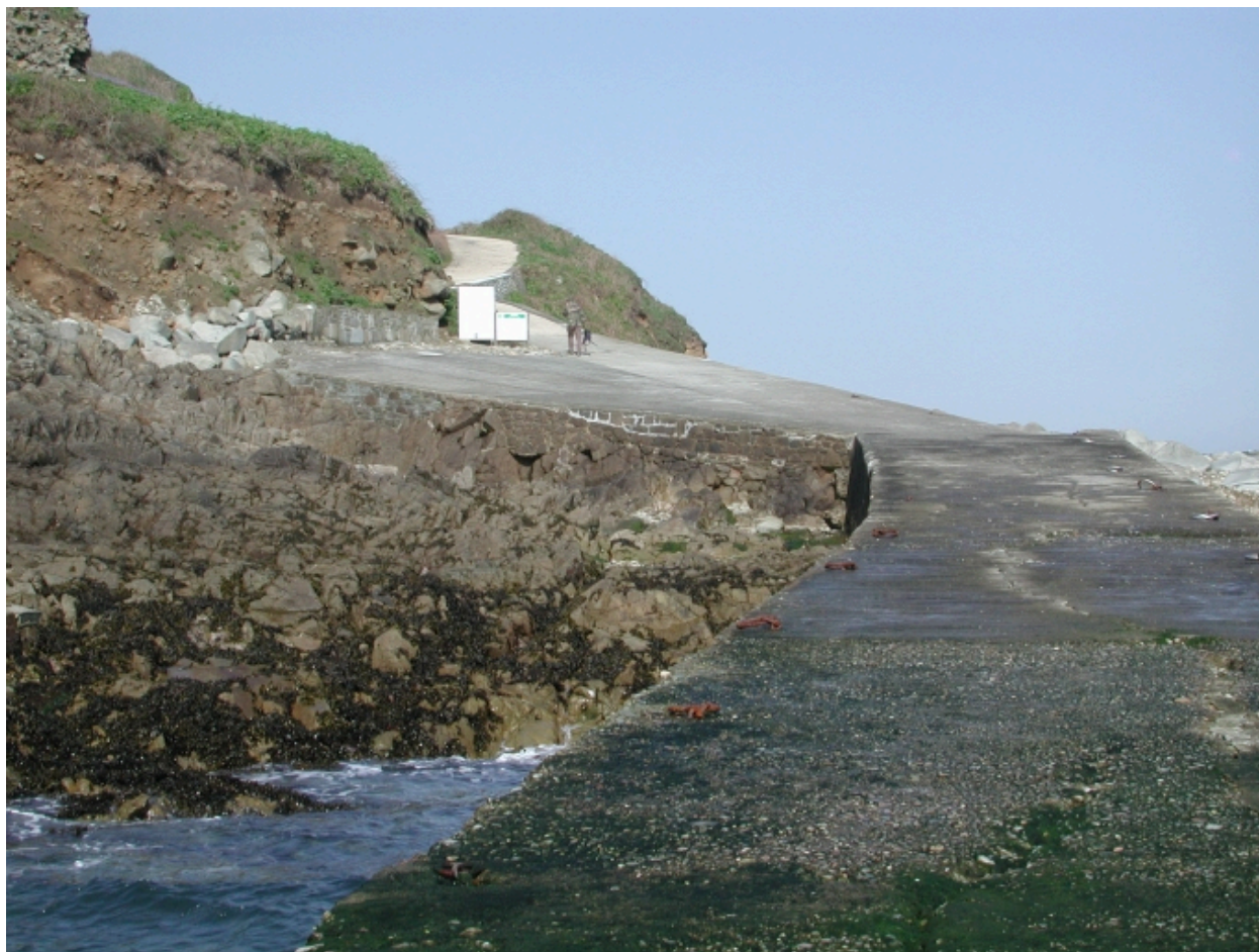
Vue de la forme du quai sud
