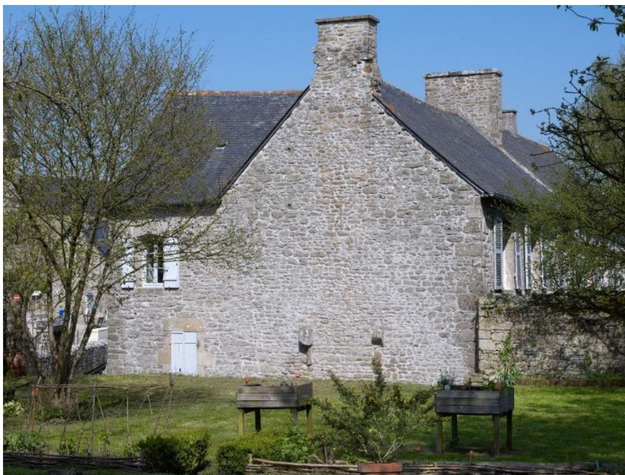
Mur pignon ouest.
