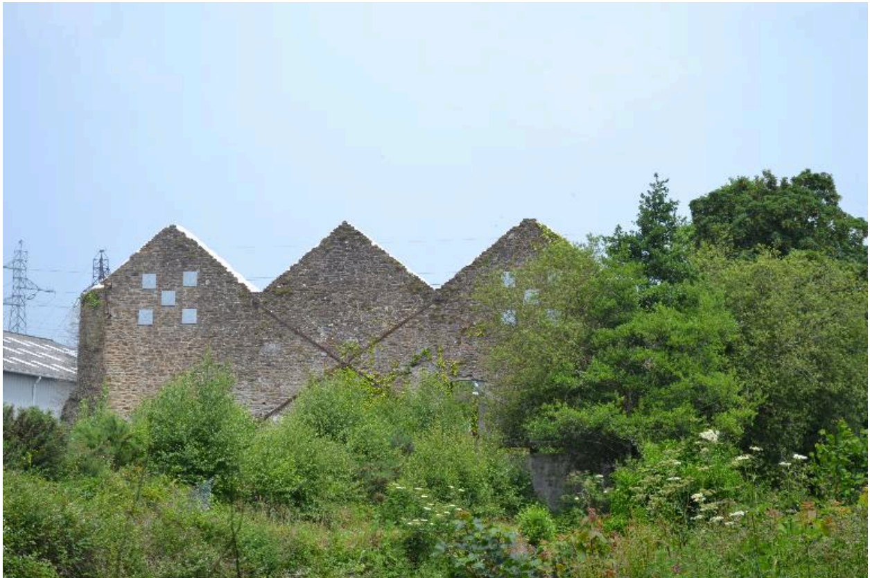
Blanchisserie. Vue de la façade ouest à trois pignons, N°2A au plan
