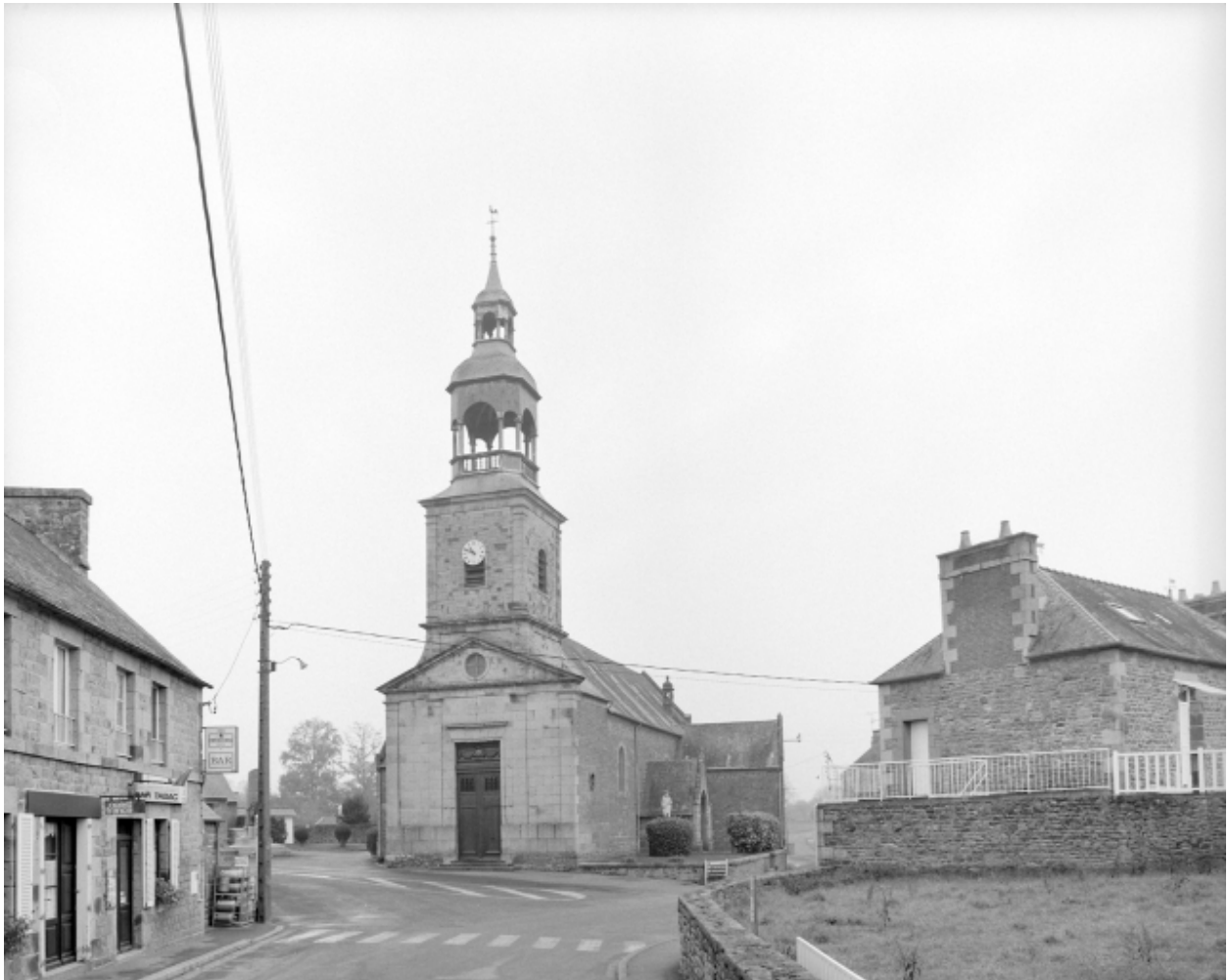
Elévation Ouest : vue générale
