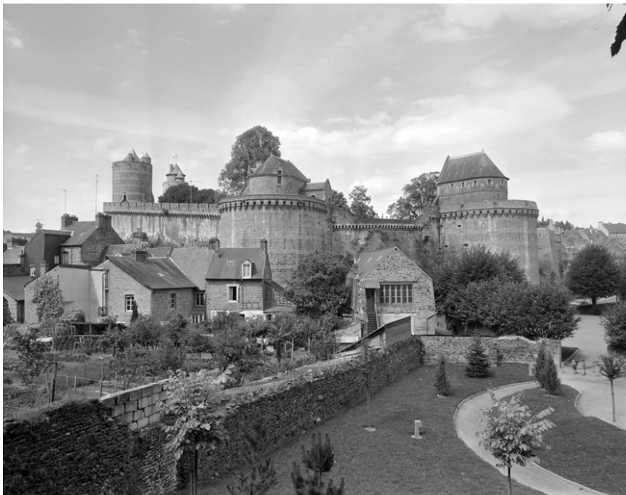
Tours de Surienne et Raoul, vue générale.
