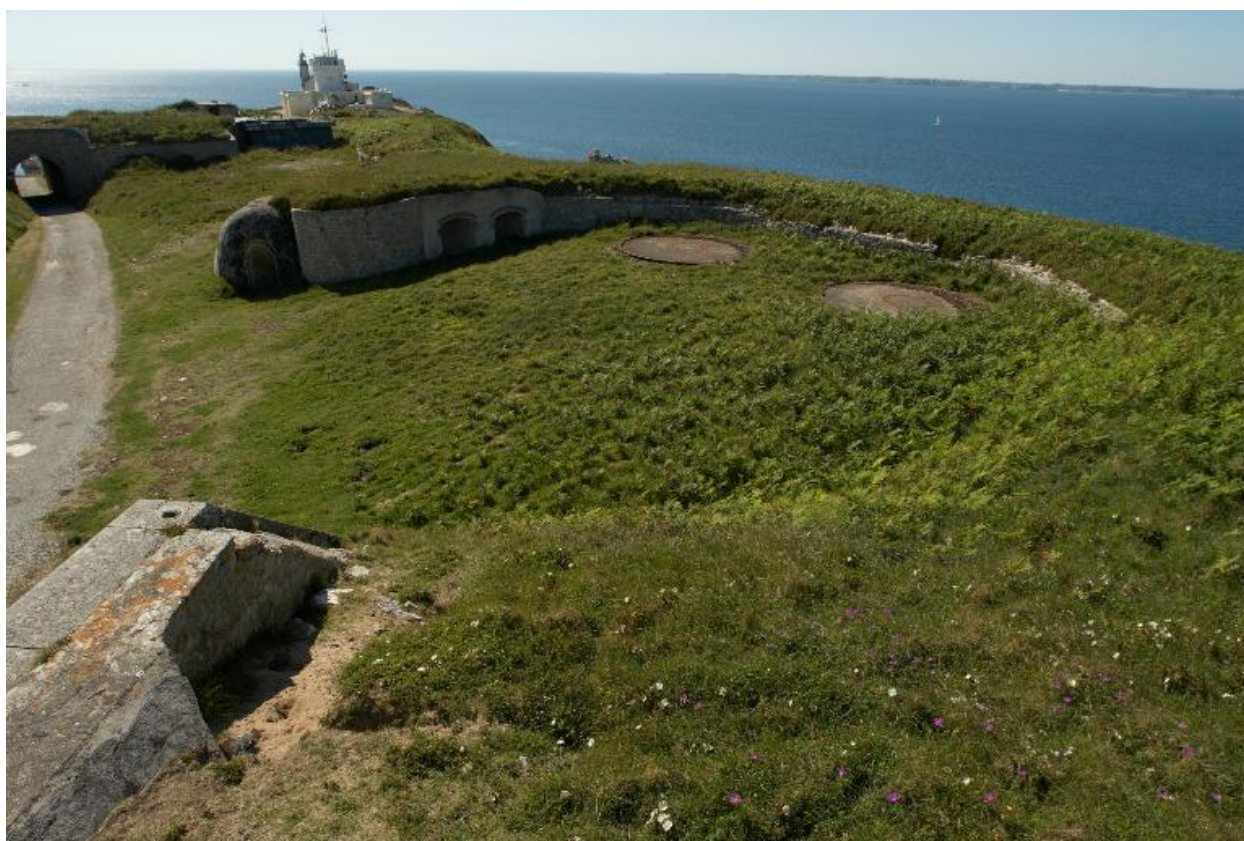
Camaret, pointe du Toulinguet : batterie de côte, plate-forme circulaire
