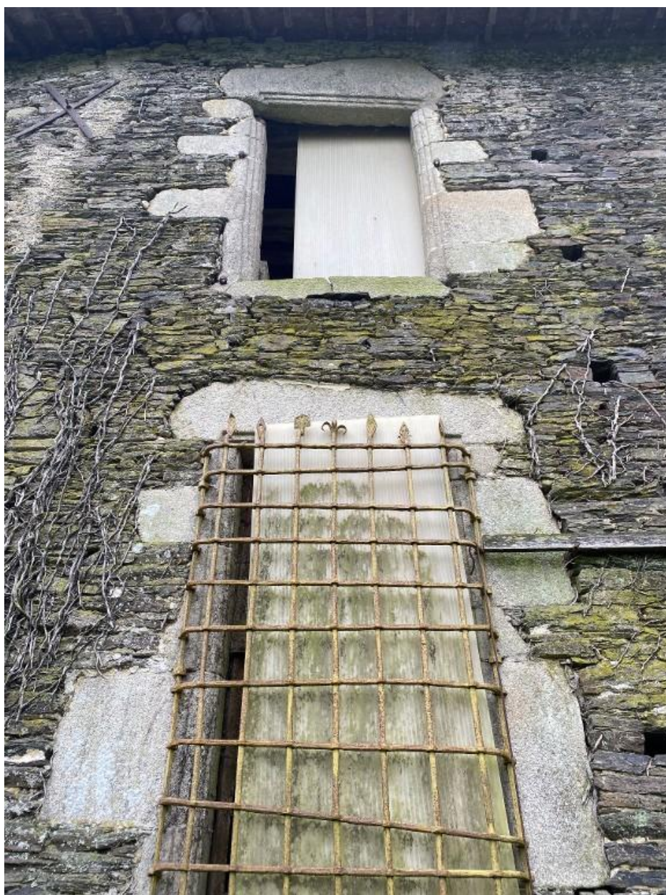
Élévation est, détail
