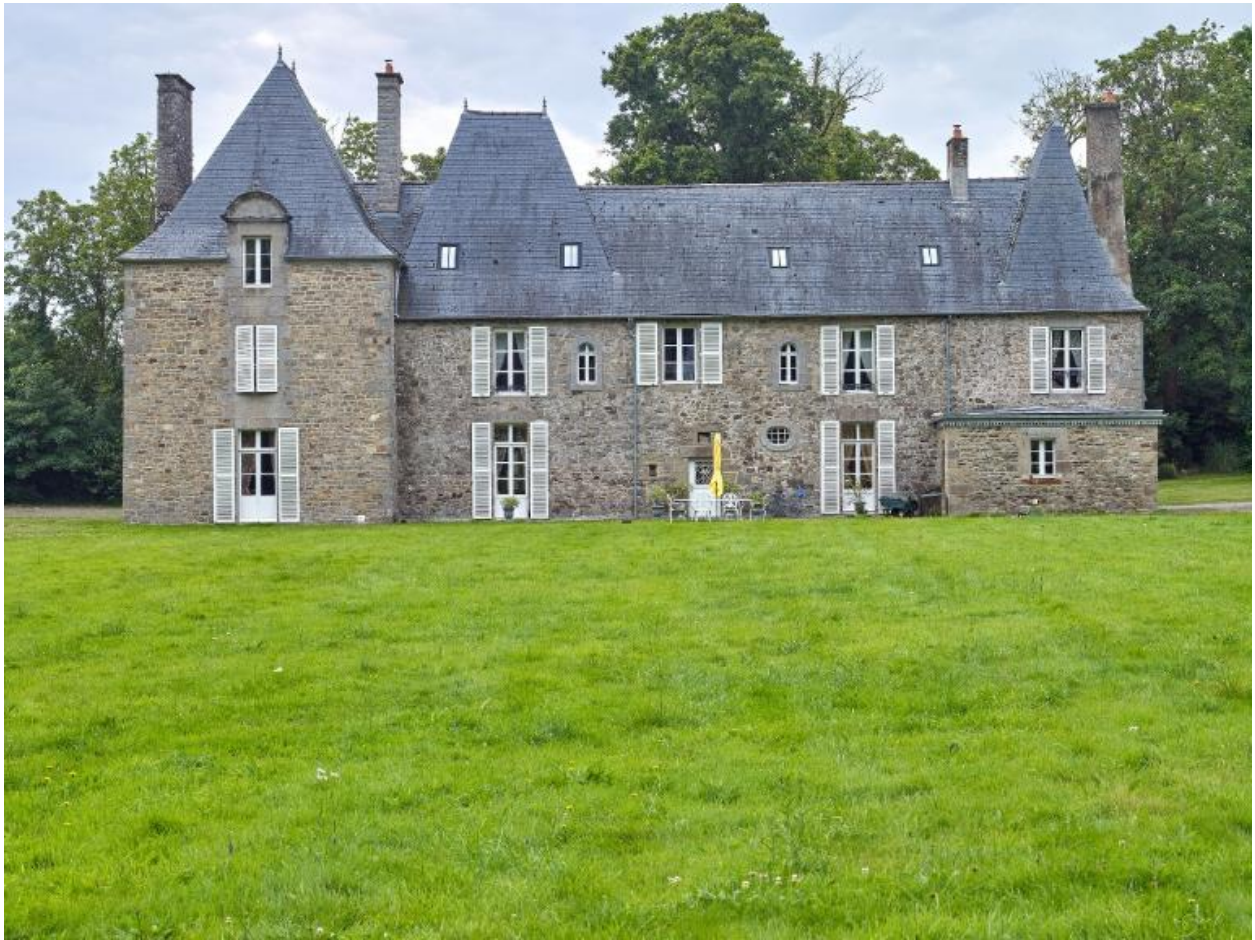
Elévation postérieure orientée vers le nord, vue générale.
