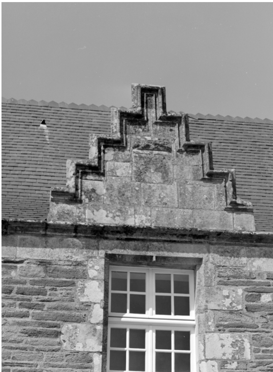
Aile nord, élévation sur cour, septième lucarne.
