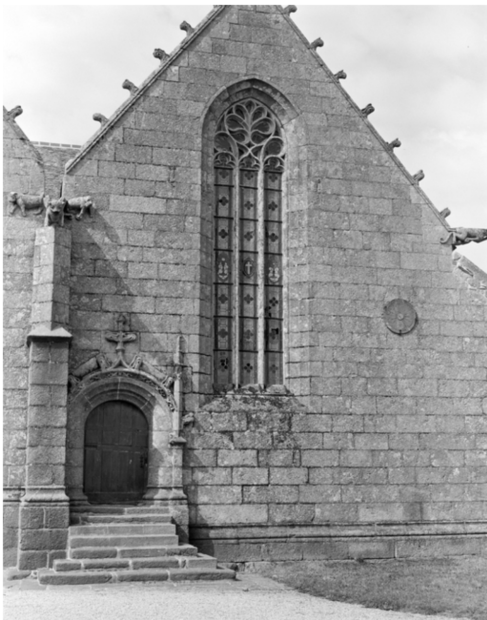
Transept, bras sud, chapelle est : vue de la fenêtre du mur sud
