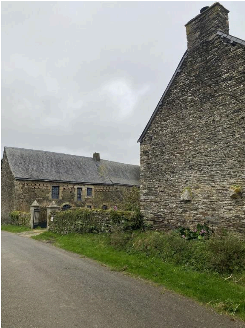
Vue sud-ouest, depuis la rue Saint-Samson
